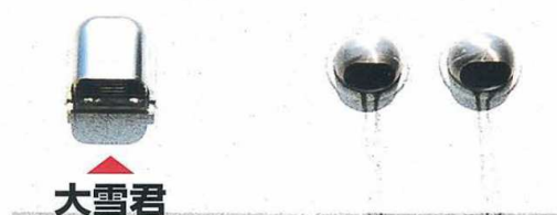
涙漏れによる外壁の変色
